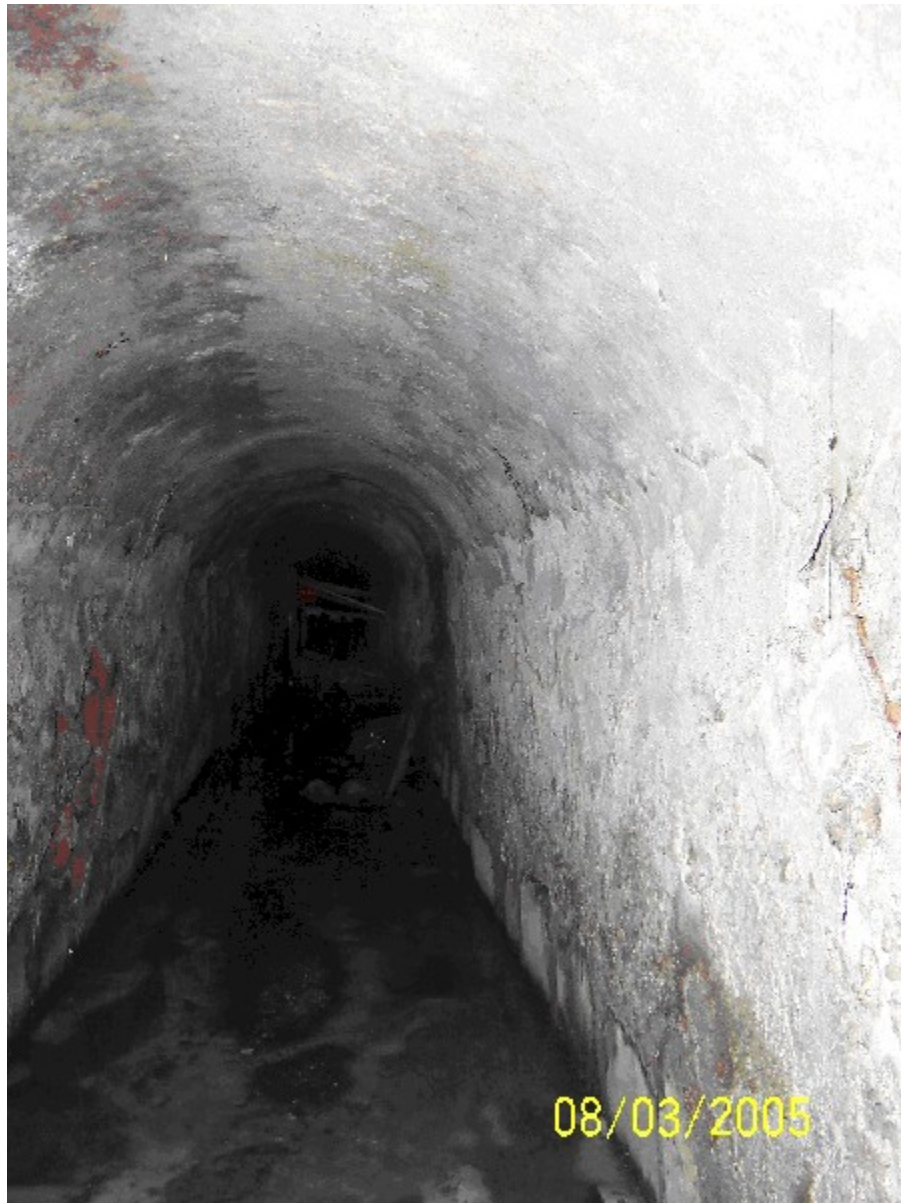
Cantiere generico intervento spazi confinati Tipo
