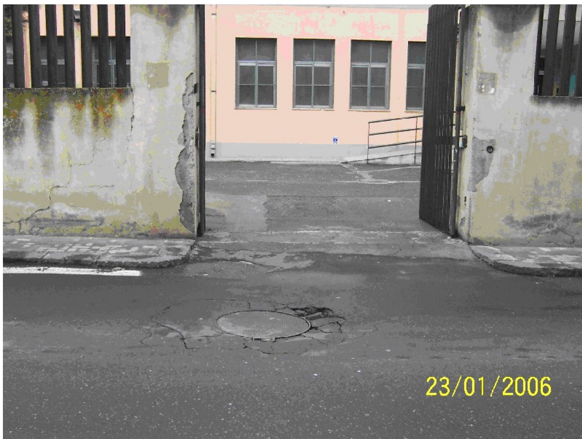
Cantiere generico intervento collettore Tipo
