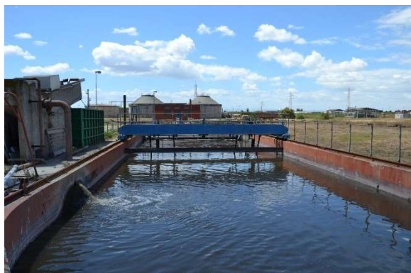
Figura 1 Dissabbiatura a canale e raccolta sabbie
