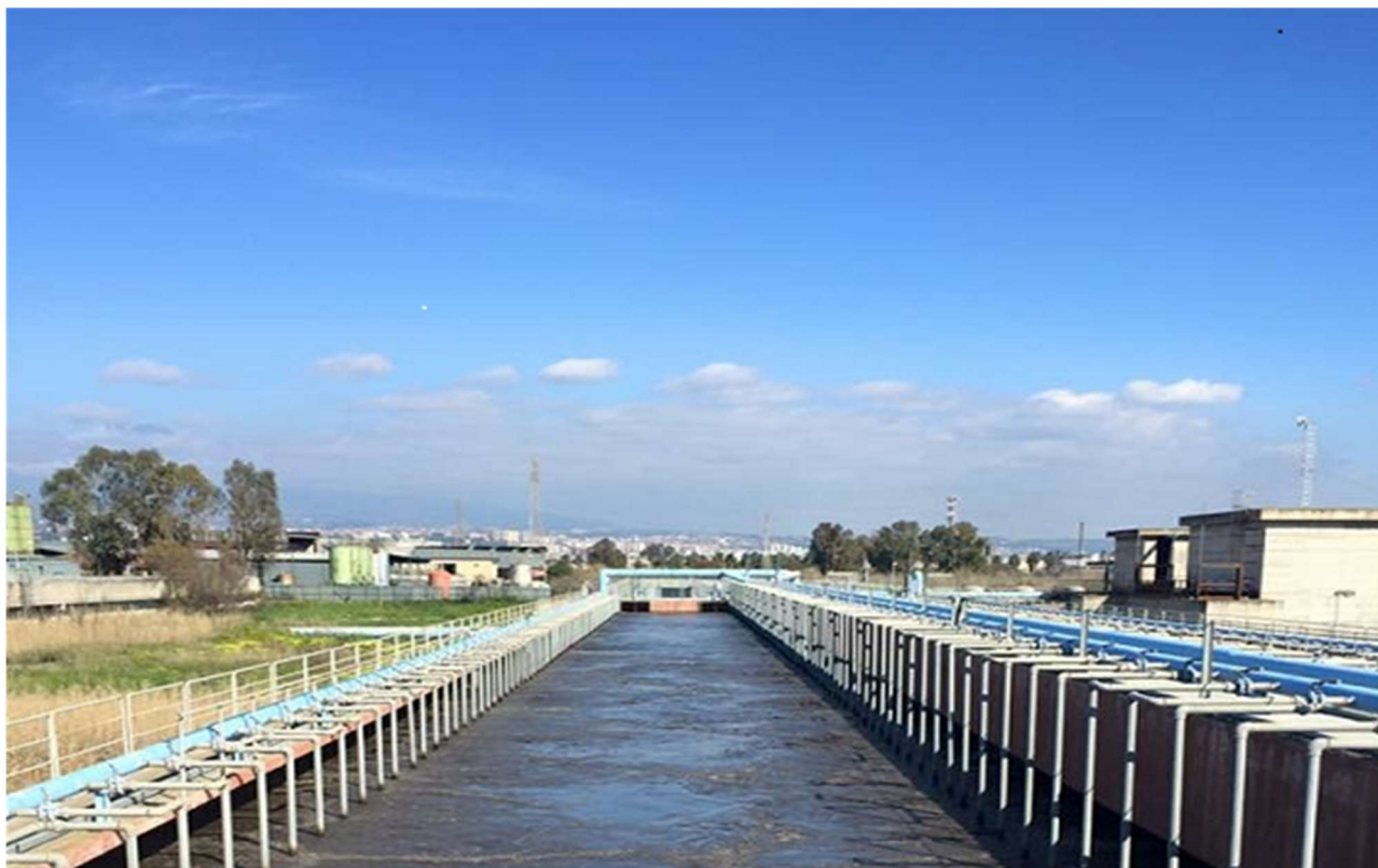
(Impianto di depurazione Pantano d'Arce CT)
